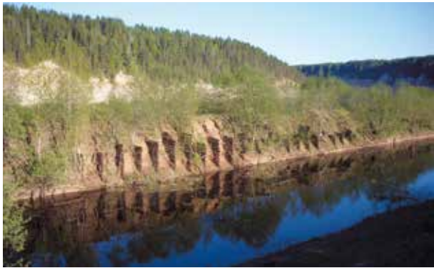
Рис. 3. Остатки ряжевых стен шлюза в Опоках
