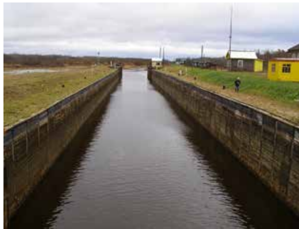
Рис. 1. Конструкция стен камер шлюзов после реконструкции
