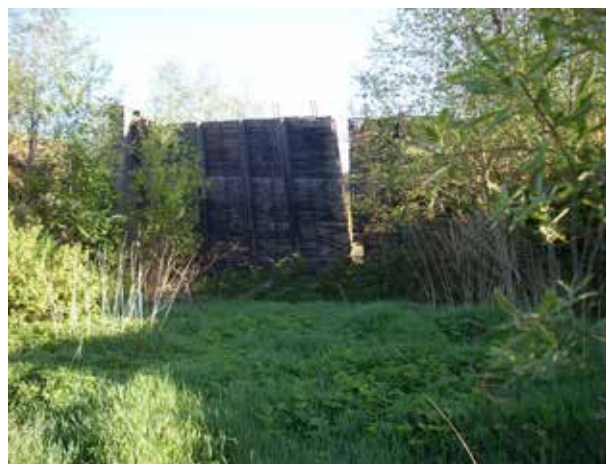
Рис. 5. Вид на верхние ворота шлюза в Опоках. 2010 г.
