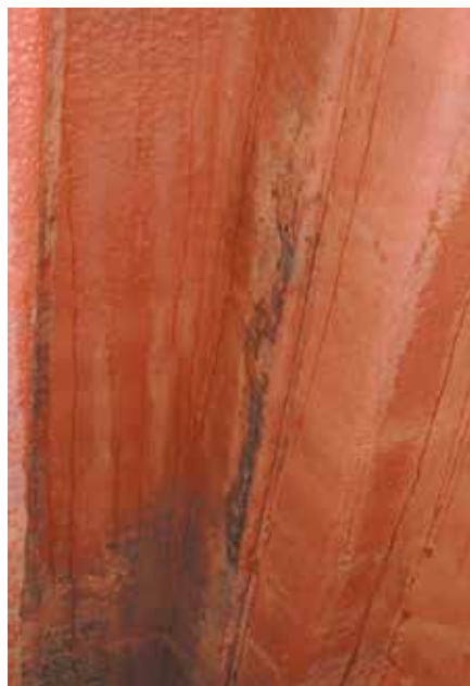
Рис. 3. Сквозная коррозия шпунта причала в Соликамске
